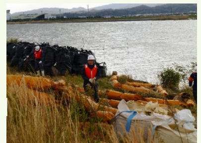
シルトフェンス設置(11/26)
