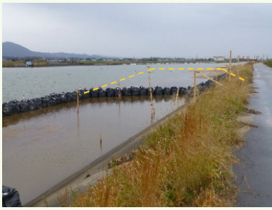
土嚢設置(点線は、築堤想像図) (11/27)
