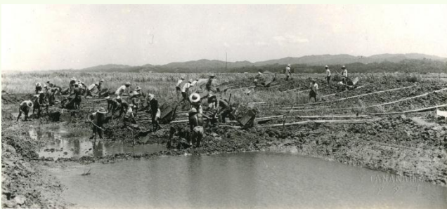
当時の築堤工事の様子
