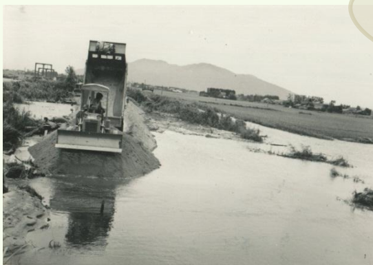
決壊した十四間川堤防の復旧工事
