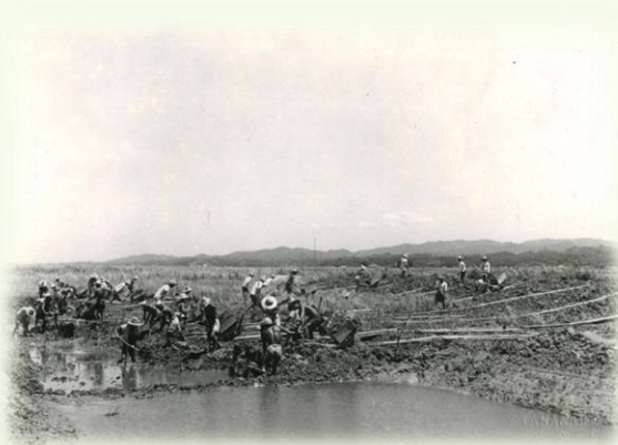
【昭和12年頃】十四間川左岸集水路掘削工事(小村宅前付近) 掘削土を十四間川堤防の盛り土に使用 左の写真には堤防越しに十四間川が見えることや写っている山並みの違いから往時と現在の堤防の高さの違いがよく分かる
